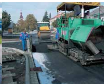
Aplikace PGM-G 100/100, komunikace Kralice na Hané, rozšíření stávajících komunikací – vyztužení asfaltu na rozšířené části
