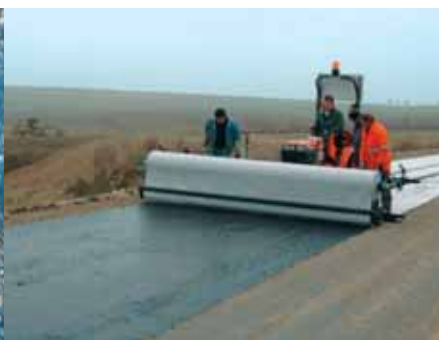
Strojová pokládka polyfeltu.PGM 14
