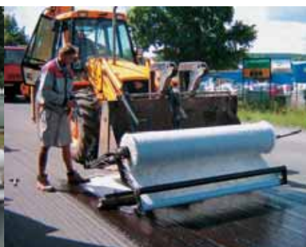
Instalace PGM-G 50/50, silnice II/37 Chrudim – Slatiňany, pokládka PGM-G
