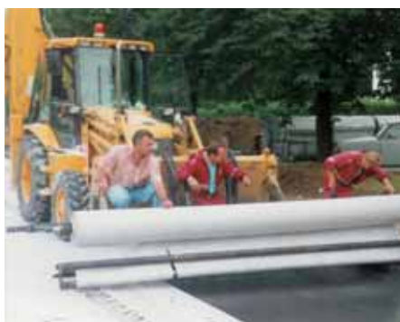
Rekonstrukce ulice Vysočanská, Praha 9-Prosek, instalace PGM 14, plošná sanace
