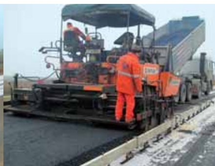
Položení bitumenové nosné vrstvy
