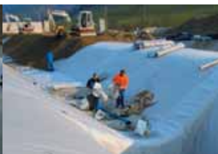
Nanášení nadnáspy přes již utěsněnou část tunelu
