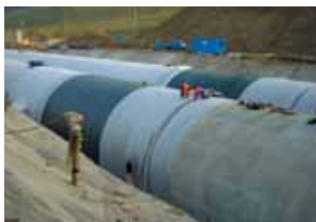
Tunel Kienberg, otevřený způsob stavby: kladení izolace
