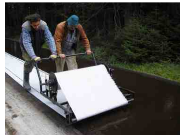
Zařízení pro ruční strojovou pokládku; pokládka pomocí tohoto zařízení; pokládka výztuže o šíři 95cm.
