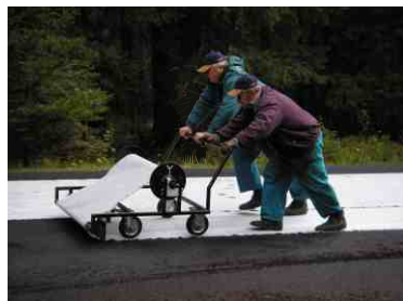
Zařízení pro ruční strojovou pokládku; pokládka pomocí tohoto zařízení; pokládka výztuže o šíři 95cm.
