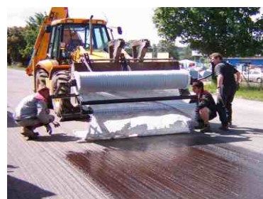
Speciální strojové zařízení zrychlí a zkvalitní pokládku. Pokládací zařízení je možné na montovat na libovolný stroj s hydraulickým zařízením vpředu.
