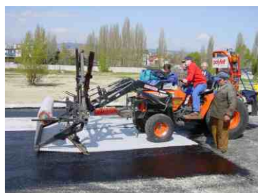
Speciální strojové zařízení zrychlí a zkvalitní pokládku. Pokládací zařízení je možné na montovat na libovolný stroj s hydraulickým zařízením vpředu.
