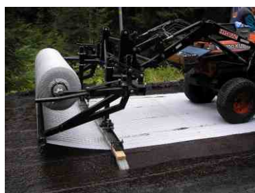
Speciální strojové zařízení zrychlí a zkvalitní pokládku. Pokládací zařízení je možné na montovat na libovolný stroj s hydraulickým zařízením vpředu.
