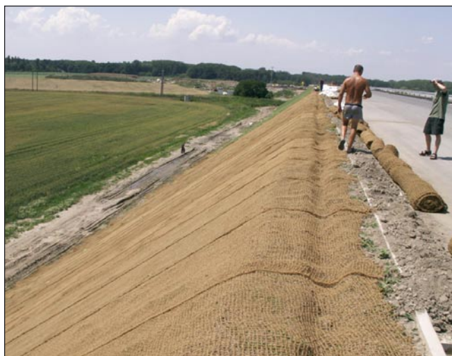
Pokládka protierozního materiálu Envirofelt CO 400
