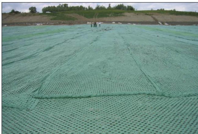
Aplikace Envirofeltu PP při rekultivaci dolu Chabařovice
