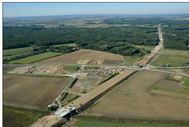
Letecký pohled na zemní těleso dálnice D11
