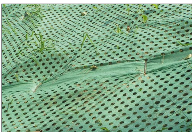
Detail ukotvení, aplikace Envirofeltu PP Vizovice
