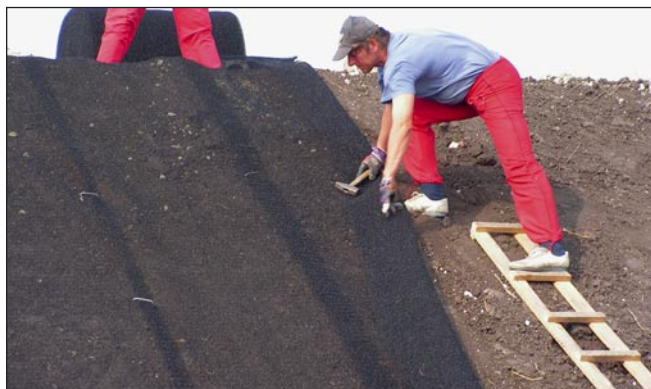
Pokládka materiálu Polymat
