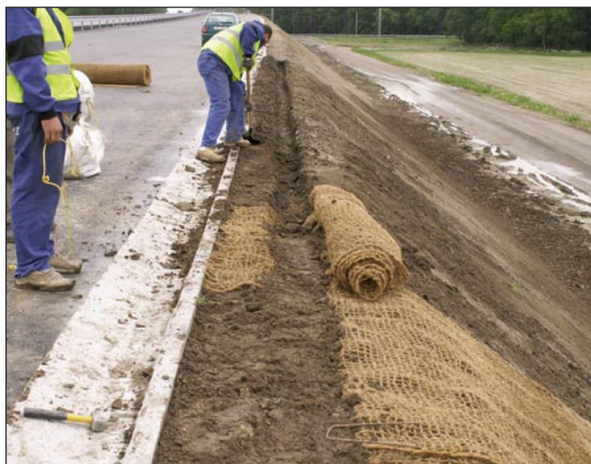
Pokládka protierozního materiálu Envirofelt CO 400
